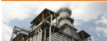
Keppel Merlimau Cogen
