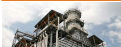
Keppel Merlimau Cogen
