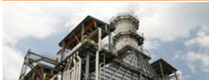
Keppel Merlimau Cogen
