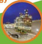
Keppel Merlimau Cogen
